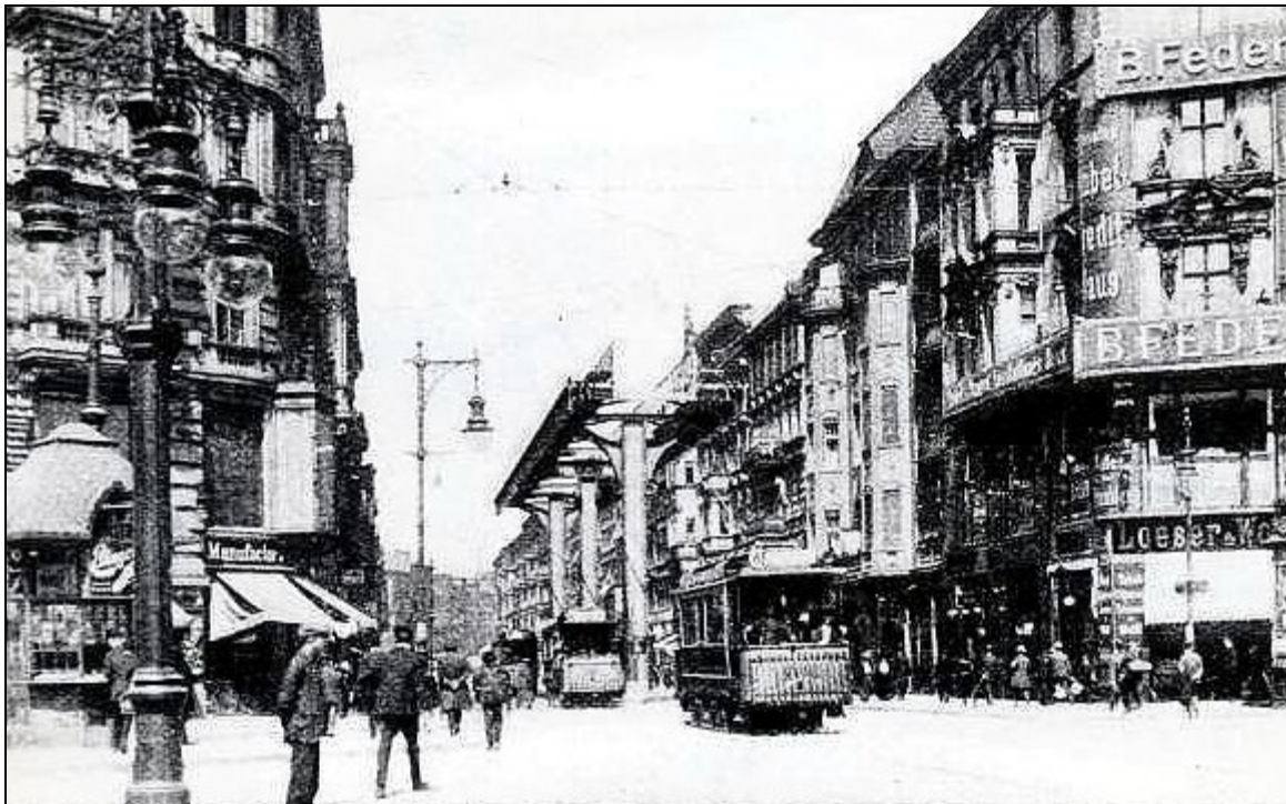
Probestrecke der Schwebebahn in der Brunnenstrasse
